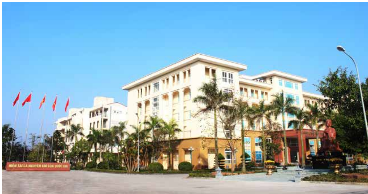
Nhà Điều hành được lắp đặt 4 phòng phục vụ hội nghị trực tuyến.
