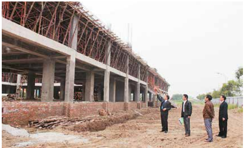
TTND.PGS.TS Vũ Đình Chính kiểm tra thực tế khối lượng xây dựng công trình Giảng đường thư viện của Trường Đại học Kỹ thuật Y tế Hải Dương (ngày 24/12/2012)
