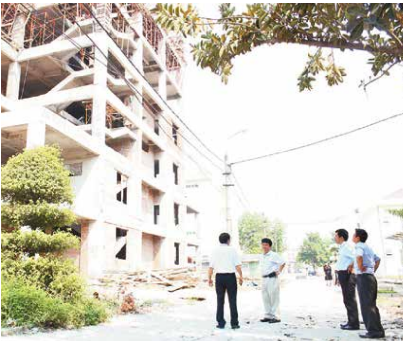
TTND.PGS.TS Vũ Đình Chính và đoàn kiểm tra giám sát đầu tư của Bộ Y tế kiểm tra công trường thuộc "Dự án đầu tư xây dựng, cải tạo, mở rộng Bệnh viện Trường"
