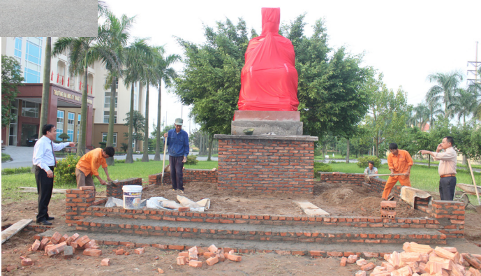
Giai đoạn hoàn thiện cơ sở hạ tầng khu Tượng đài
